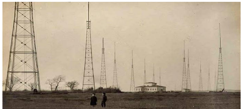
Foto a lato - una vista della stazione di Coltano nel 1911, che rende evidenti le dimensioni degli impianti.
