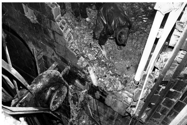
Un rottame del B-25 nel vano dell'ascensore al 79esimo piano
