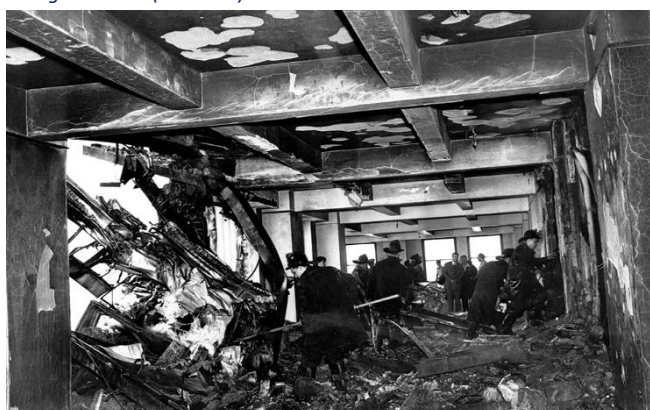
Foto sopra, a lato e sotto: L'interno dell'Empire State Building tra il 78° e il 79esimo piano dopo lo schianto dell'aereo
